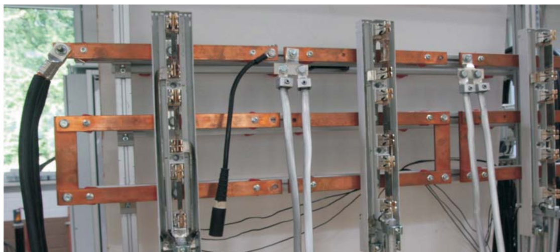
fot. 13. Badanie trzech rozłączników z zaciskami piętrowymi typu V (z nową przekładką)
