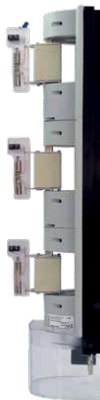
Zdj. 24, 25. Kontrola stanu wkładek bezpiecznikowych przy wykorzystaniu zestawu ELEGARD.
