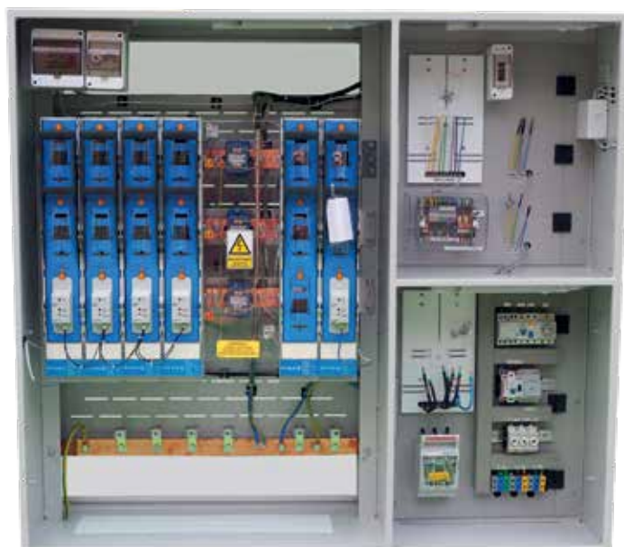
Zdj. 6. Przykład rozłączników bezpiecznikowych NSL E3 z kontrolą przepalenia wkładek bezpiecznikowych w rozdzielni produkcyjnej PRE EDWARD BIEL
